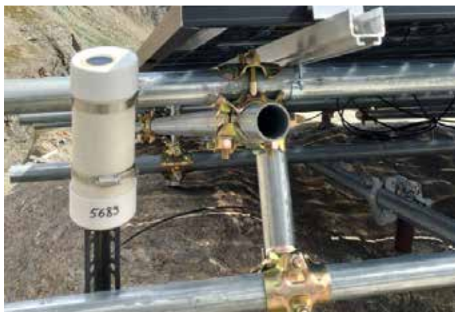
Figura 25 - Strumento SQM matricola 5689 del CNR installato presso il Rifugio Chiarella - ph I. Cabona
