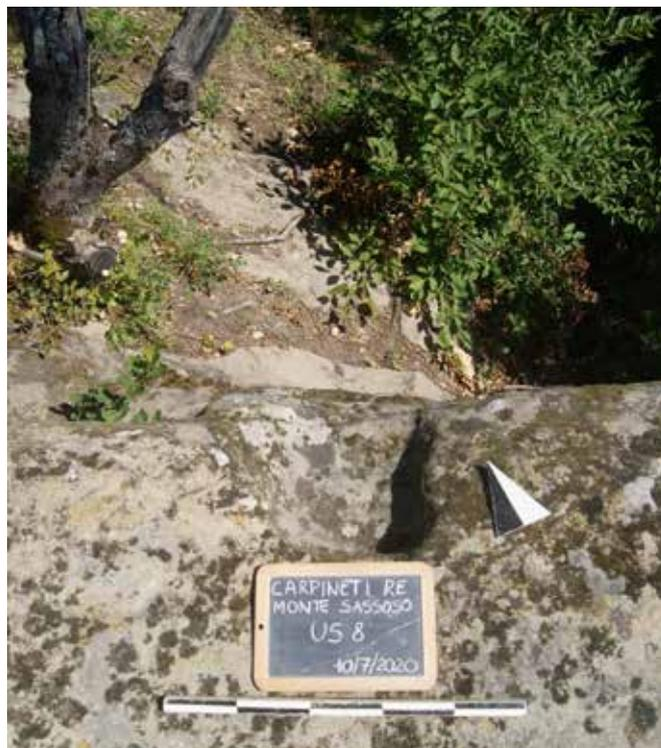
Fig. 3 - Area Sud, una delle buche per alloggio di trave orizzontale
