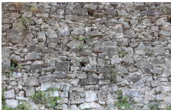
Fig. 84 – Monte Bastiglia. Versante Sud, muro di contenimento del terrazzamento. Particolare della tecnica costruttiva (foto Alfredo Nicastri)
