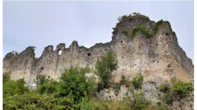
Fig. 70 – Castel Vetrano, Fuorni. Particolare della cinta muraria, angolo Nord Ovest. È ancora riconoscibile parte della merlatura con aperture adatte anche all'uso delle armi da fuoco (foto Alfredo Nicastri)
