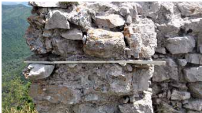
Fig. 78 - Monte Bastiglia. Particolare delle mura della cappella (larghezza cm 90 ca.). Si può notare la scarsa connessione tra le pietre, compensata dall'abbondante utilizzo di malta, ed anche la ridotta dimensione del diatono in basso a sinistra, che non supera la metà dello spessore del muro (foto Alfredo Nicastrì)
