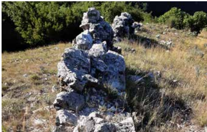
Fig. 79 – Monte Bastiglia. Mura orientali, particolare della sezione. Come si può notare i due pannelli esterni sono scarsamente connessi al nucleo a causa dell'assenza di diatoni (foto Alfredo Nicastrì)
