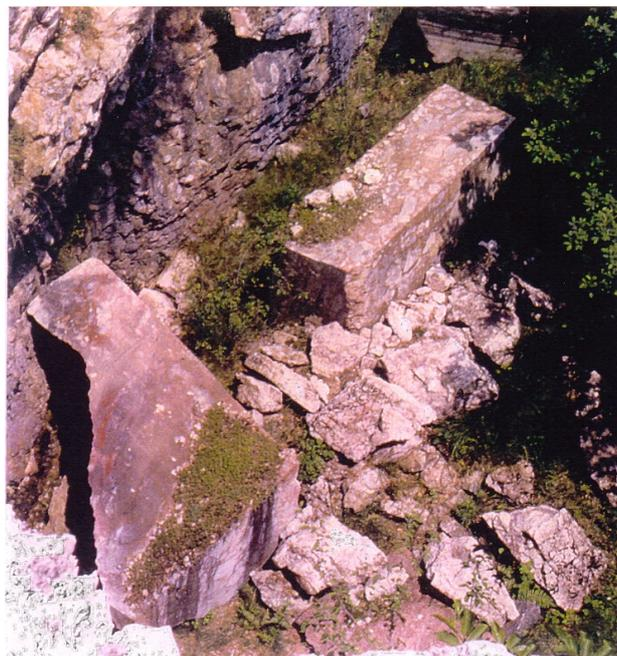
Fig. 8 - Tracce di lavori di estrazione del Persichino di Val Corsaglia nella cava all'imbocco del Rio Sbornina (sponda sinistra).
