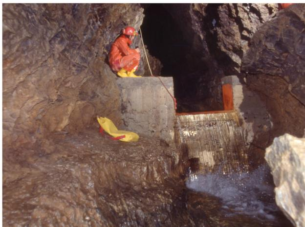
Fig. 2 - La diga con la bocca a stramazzo sul collettore del sistema carsico (Torrente Mora).
