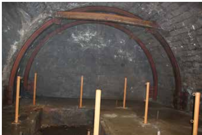
Foto 12: Centine di rinforzo di una "Cappella" (foto L. Cavinato)
