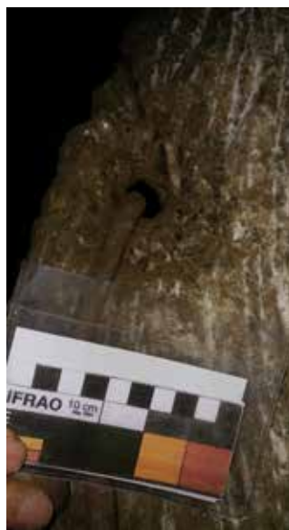
Fig. 42 - Foro artificiale passante
