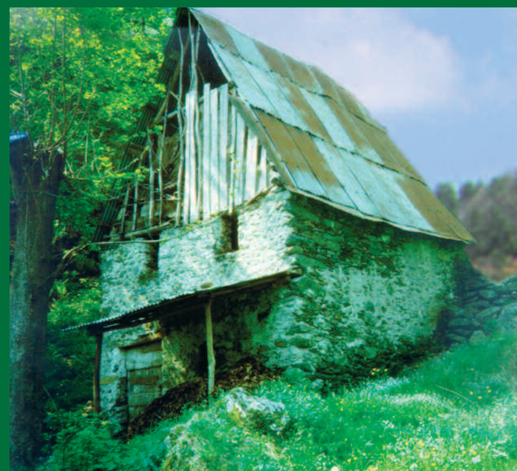
I fabbricati, solitamente a pianta rettangolare, presentano ingressi contrapposti: quello rivolto a valle introduce in un seminterrato destinato a stalla-fienile, mentre verso monte si apre l'accesso ad un vano che accoglieva la famiglia contadina; la muratura è in pietra.
