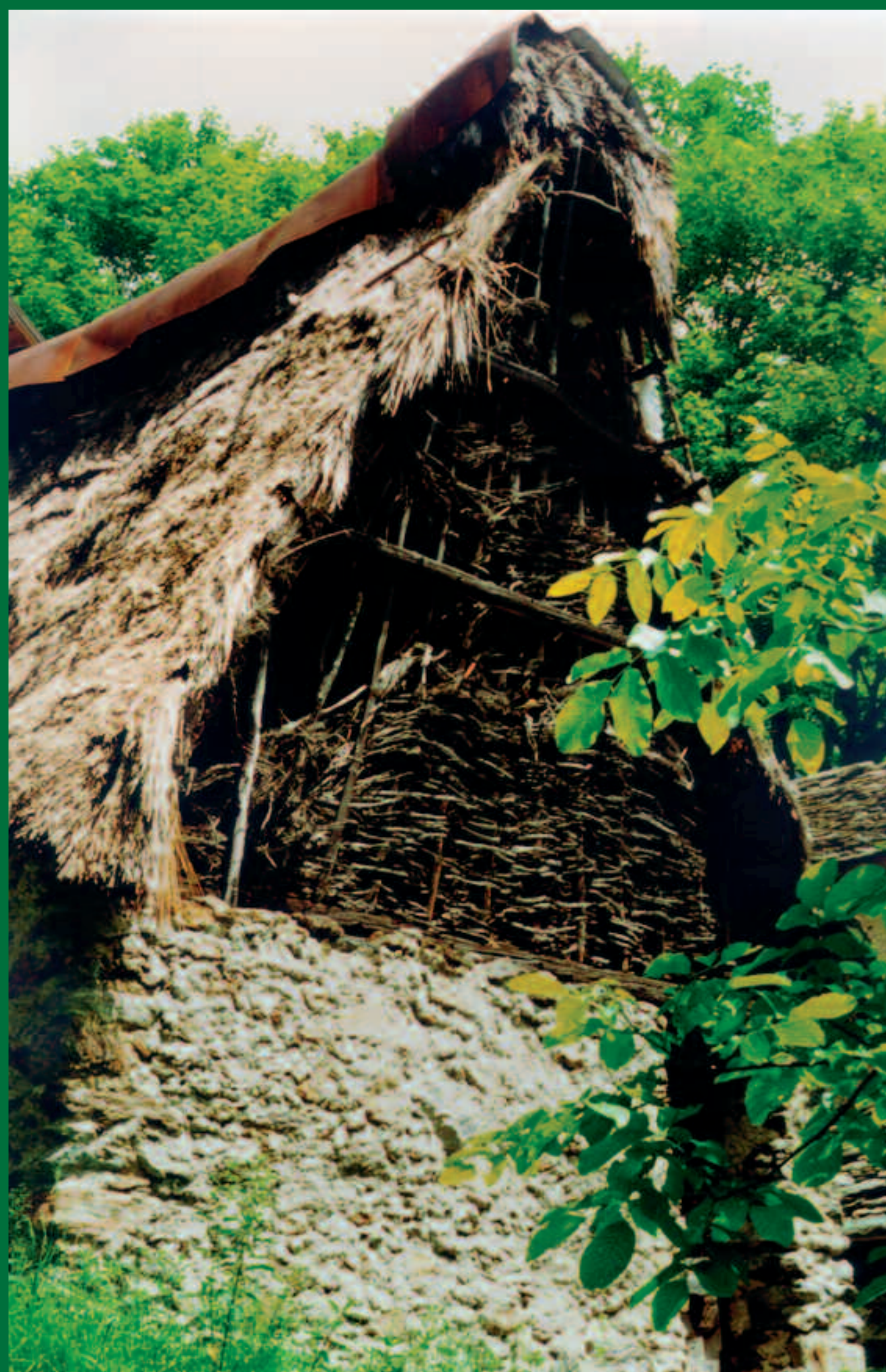
Case dai tetti di paglia: la durata di un tetto era di circa trent'anni; resisteva alla pioggia ed al carico della neve grazie alla sua forte pendenza. L'aerazione veniva ottenuta costruendo gratucci con rami di nocciolo.
