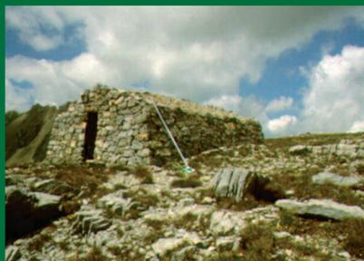
Sulle Alpi cuneesi è possibile ritrovare costruzioni in pietra a secco (con volta a botte) dette “trune”, talora ubicate anche a quote elevate, come questa sulla cima di Test a 2.660 m.
