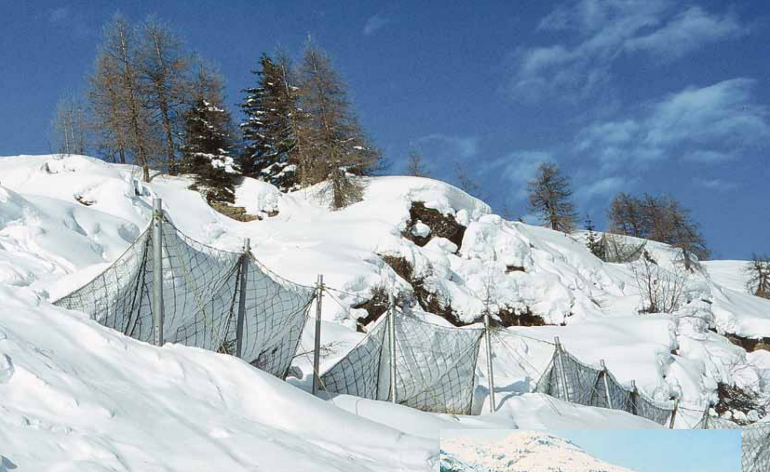
Sopra: reti metalliche.
